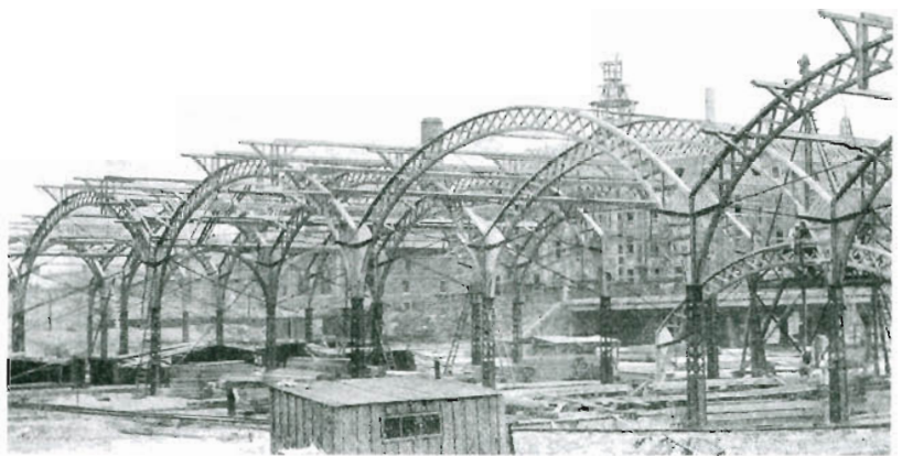
Bild 2.19: Bahnhof Kopenhagen, Spannweite: 19,2 m a) Bahnhof im Bau (aus [2.12])
