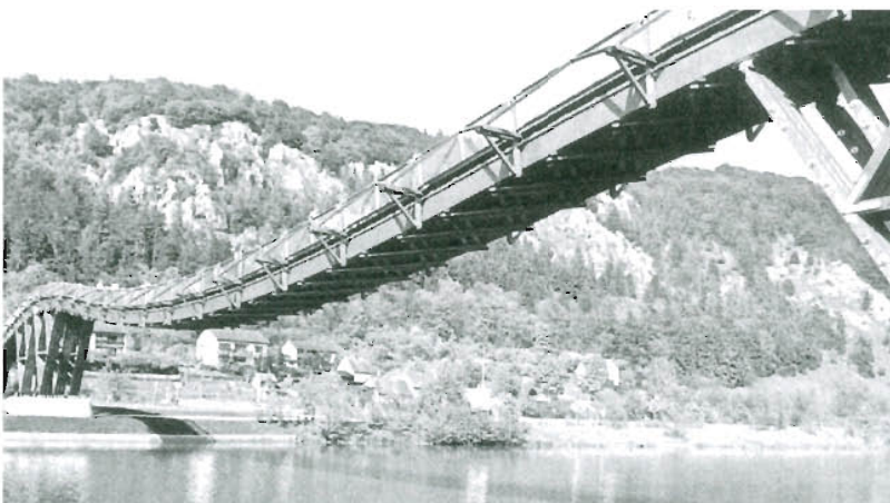
Bild 3.18: Fußgängerbrücke über den Main-Donau-Kanal bei Essing im Altmühltal, Tragwerk: Spannband, Spannweite: 30, 32, 73, 35 m, Ausführung:
