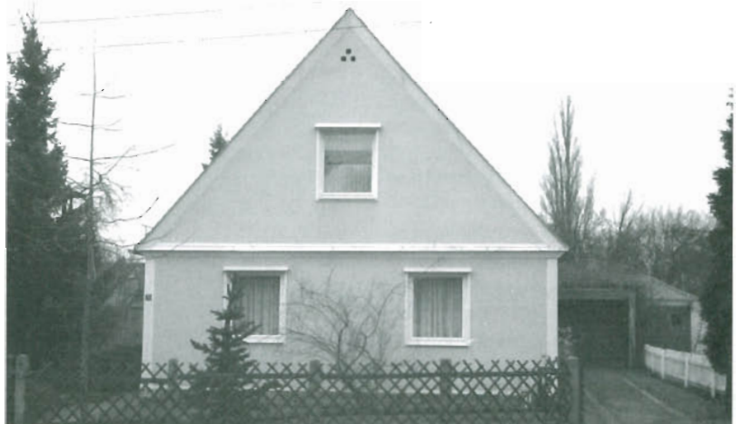
Bild 2.68: Weiterentwickelter Fachwerkbau für Kleine Siedlungshäuser nach dem Patent von Heinrich Tessenow, (Foto eines Siedlungshauses in Dresden Hellerau, erbaut 1911, Prof. Rug, Zustand 2001)
