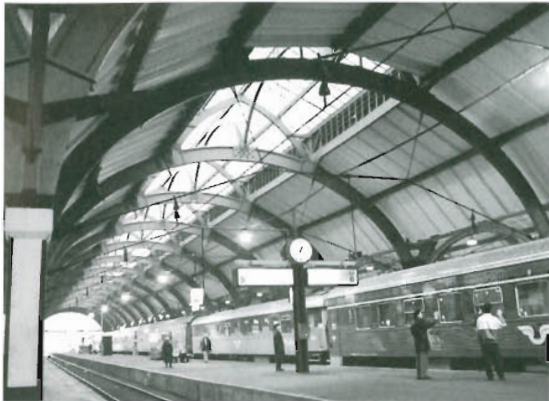
Bahnhofshalle Malmö, 1923 erbaut in Hetzerbauweise, vierschiffige Anlage, Spannweite: 17,9 m, Heutiger Zustand (Foto: C. Magnusson, Malmö)
