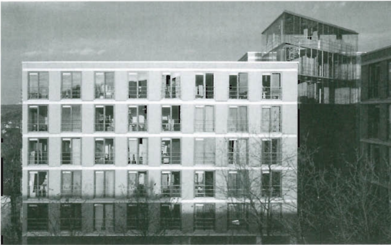
Bild 3.15 Umbau eines Beton-Plattenbaus mit Verbesserung der Wärmedämmung (Passivhausstandard), Studentenwohnheim Wuppertal, Ausführung: Fa. Lux, GmbH, Roth 1999/2000 (aus [4.34])
