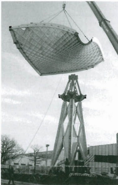
b) Montage eines Schalenelementes
