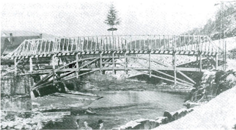
Bild 3.17 b) Brückenneubau ohne Eindeckung und Verschalung
