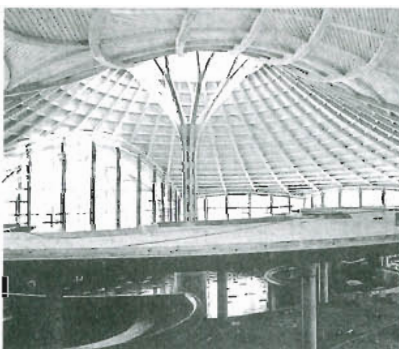
Bild 3.28: Holz-Rippenschale aus Brett-schichtholz, gestützt von 5 Baumstützen, überspannt ein Erlebnisbad, Solebad Bad Dür rheim, Ausführung: Fa. Chr. Burg-bacher Holzwerk, Trossingen, mit Zimmermeister M. Jörg und G. Arno, 1987 (Bilder aus „bauen mit holz“ [1987] 5)
