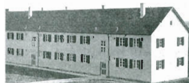
b) fertig verputztes Gebäude, Putz auf Heraklith-Platten, Ausführung: Zimmermeister Bosch, 1950 (aus [3.8])
