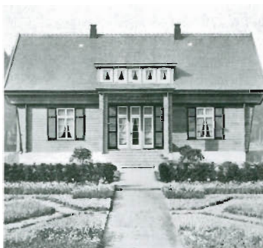
Bild 2.55: Bürgerliches Wohnhaus auf der Dresdner Ausstellung „Jahresschau“, 1925, Architekt: Prof. Albin Müller, Blockbauweise aus genormten Schnittholzböhlen 7x16 cm für Außen- und Innenwände, Produzent: Christoph & Unmack (aus [2.143])
