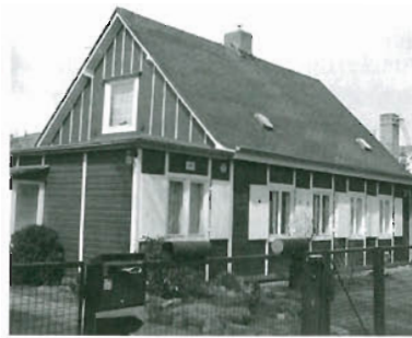
Bild 2.59: Siedlung für Wohnungslose des Wohnungsverbandes Groß-Berlin in Adlershof, Doppelhäuser als Einheitstyp, Tafelbauweise, mit ca. 80 m 2 Wohnfläche pro Haushälfte, Planung und Ausführung: Christoph & Unmack, 1919, (Foto: Prof. Rug, Zustand 2001)
