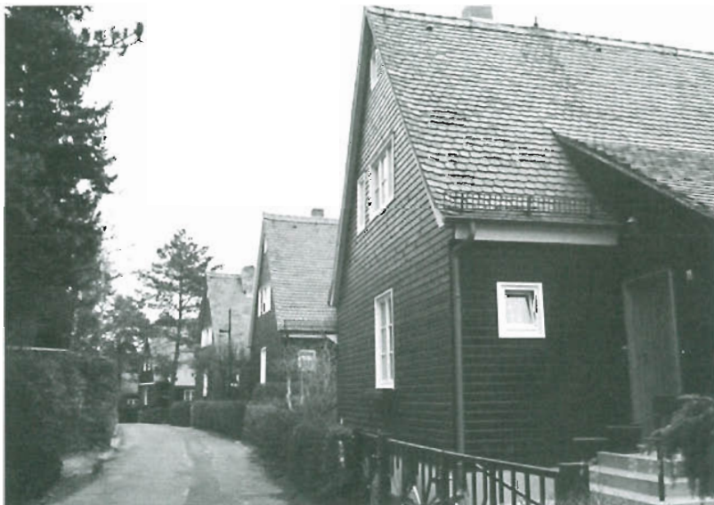
Bild 2.62: Holzhausssiedlung Dresden-Hellerau, Architekten: Wilhelm Kreis und Eugen Schwemmler, „Jalousiebau-Weise“ Ausführung: Deutsche Werkstätten Hellerau, (s. [2.104]), (Foto: Prof. Rug, Zustand 2001)
