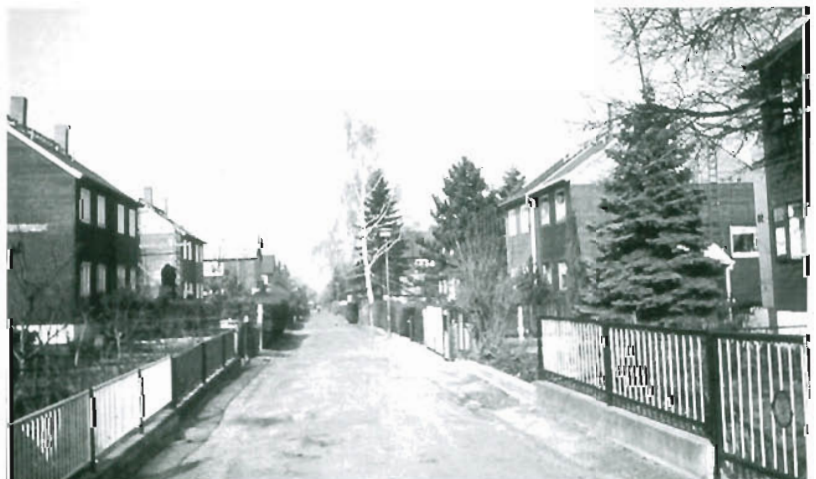
Bild 9.2: Holzhäuser der Firma Christoph und Unmack, errichtet 1927, Dresden-Neuost, produziert und errichtet nach den Regeln der DIN 1990 (heutiger Zustand zu Bild 2.66 – Foto: Prof. Rug, 2001)
