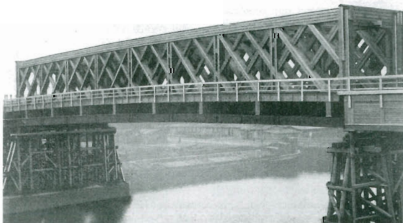
Bild 2.72: Brücke bei Kehl am Rhein, Tragwerk im Bereich der Schifffahrtsöffnung, Spannweite: 50 m, Entwurf: Prof. Gaber, Karlsruhe, 1940 (aus [3.35])
