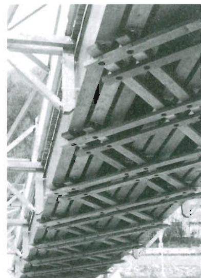
b) Unteransicht mit Aussteifungsverband
