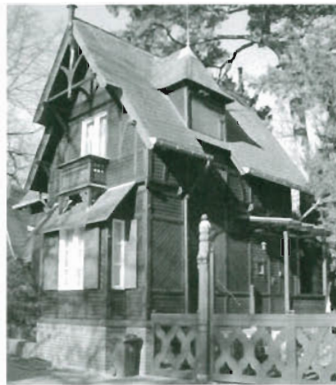
Bild 2.54: Haus Berlin-Wannsee, Holztafelbau, Architekt: Johannes Lange, Berlin, Wolgaster AG für Holzbearbeitung, 1890 (Foto: Prof. Rug, Zustand 2001)
