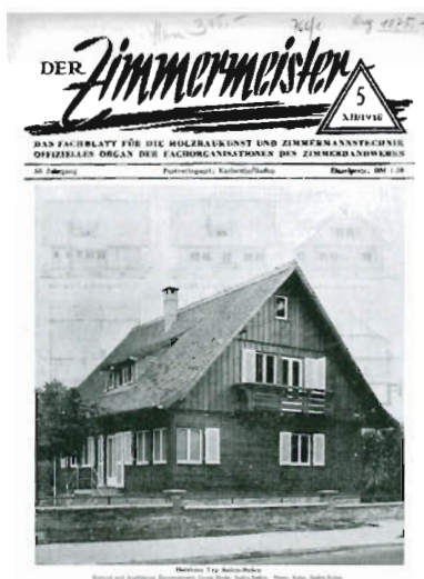
Bild 3.12 Holzhaus in Holztafelbauart, 1948, Entwurf und Ausführung: Zimmermeister Hecht, Baden-Baden (Foto aus Der Zimmermeister (1948) 5, Titelblatt)
