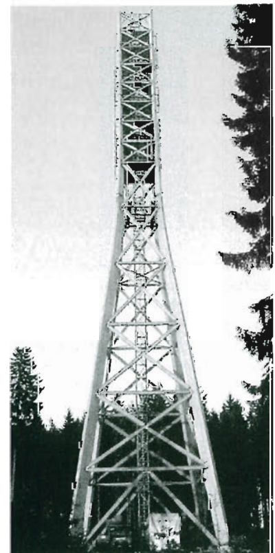
Bild 2.77: Mobilfunk-Turm, Höhe 66 m, Ausführung: Holzbau Gröber, Füraamoos, 2002 (aus [2.221])
