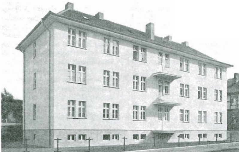
b) Nach Fertigstellung
