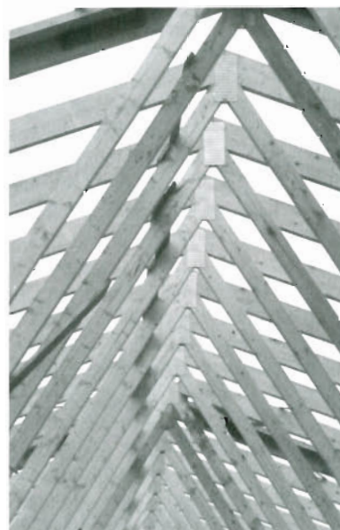
Bild 3.22 Anwendung von Nagelplattenbindern beim Bau von Einkaufsmärkten, (Foto: Prof. Rug)
