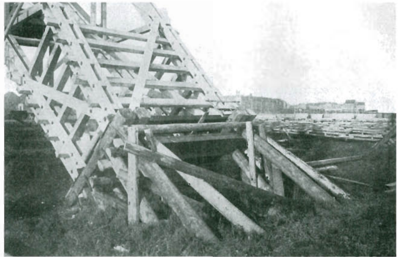
Bild 2.25: Foto von der Sängerbund Festhalle Dresden, Spannweite: 78 m, Hallenlänge: 132 m, Binderabstand: 12,90 m, Scheitelhöhe: 20,50 m, 1925 (aus [2.224]) a) Gründung
