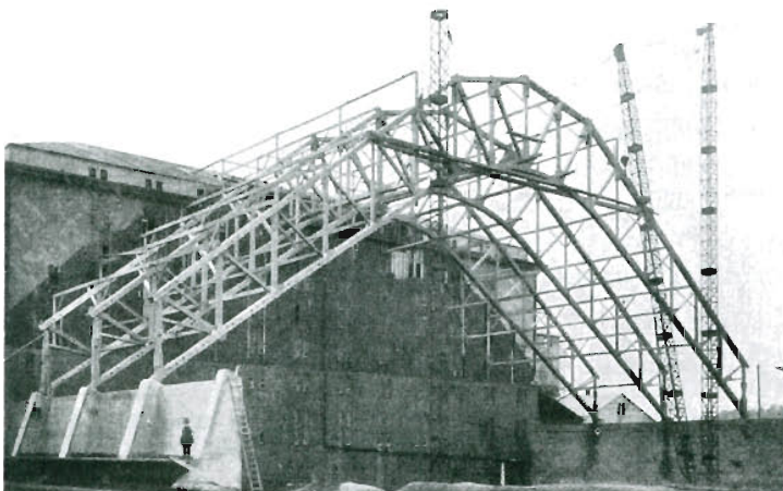
b) Die ersten montierten Binder
