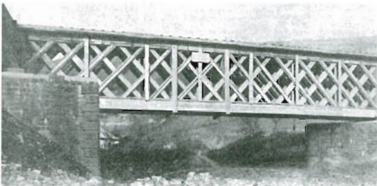
Eisenbahnbrücke über die Pfinz bei Grötzingen, Spannweite: 30 m, 3 genagelte Fachwerkträger im Abstand von 1,0 m bilden die Haupttragkonstruktion Entwurf: Prof. Gaber, Karlsruhe, Ausführung: Zimmermeister Winter, Durmersheim, 1948
