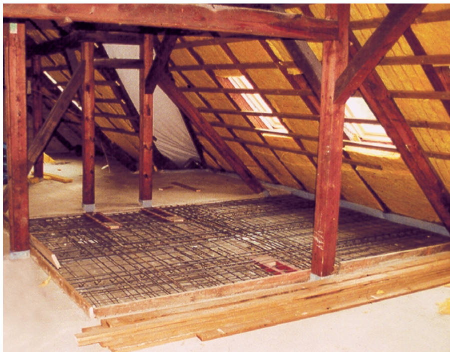
Ertüchtigung einer Holzalkendecke im Dachgeschoss durch Anwendung der Holzbetonverbundbauweise Foto: Prof. Dr.-Ing. W. Rug
