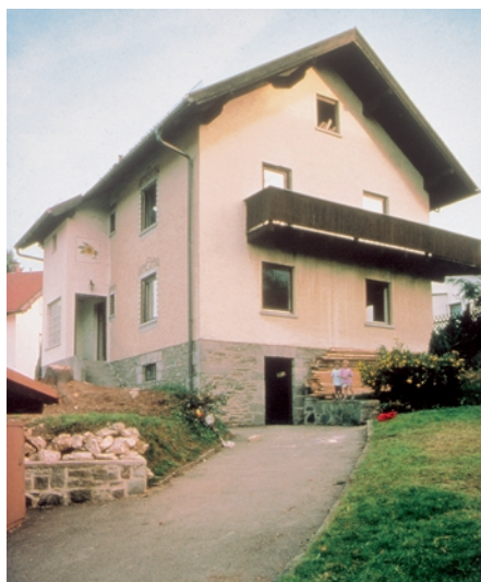
Sanierung eines Hauses
