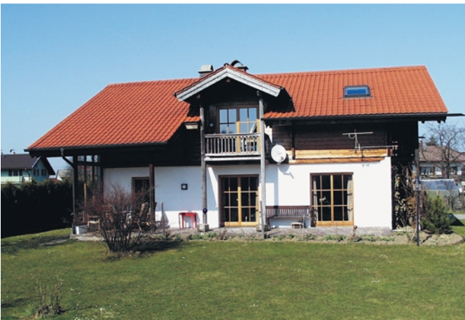
Ursprünglich gemauertes Haus, Baujahr 1964, wird vollständig renoviert. Neuerrichtung von Obergeschoss (in 2-schaliger Holzblockkonstruktion mit zwischenliegender Wärmedämmung) und Dach, außenseitiger Vollwärmeschutz am Außenmauerwerk EG. Einbau von Glaselementen mit Wärmeschutzglas 1,1 W/m 2 -K, alle Elemente mit Spaltlüftung a) Ursprünglicher Zustand b) Umbauphase c) Zustand 2002 (zehn Jahre nach der Renovierung)
