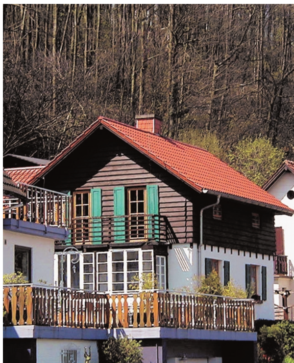
Modernisiertes Einfamilienhaus in Mischbauweise (Untergeschoss Massiv-, Obergeschoss Fachwerkbauweise), in den dreißiger Jahren des 20. Jahrhunderts errichtet (Neustadt Weinstraße) Foto: Dipl.-Ing. Thomas Strauß
