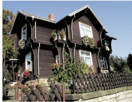
Blockhaus in industrieller Holzbauweise, Baujahr 1904 – bei Erhalt der holzsichtigen Fassade ist nur eine wärmetechnische Ertüchtigung von innen möglich, siehe Beispiel 4 in Tabelle 4.4
