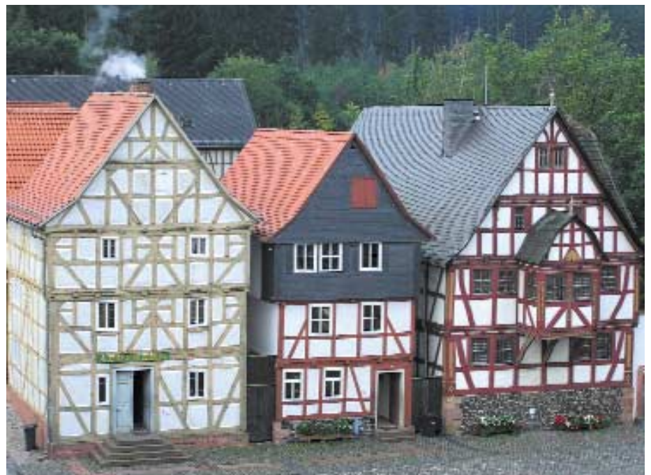
Abb. 1.2: Historisches Fachwerk, wiederaufgebaut im Freilichtmuseum Hessenpark
