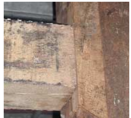
Abb. 4.7: Reparatur einer Zapfenverbindung
