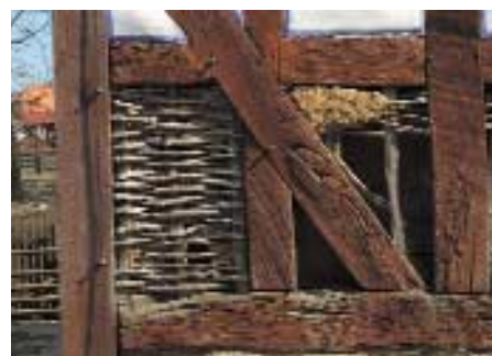
Abb. 2.9: Gefache aus Stakung, Weidengeflecht und Strohlehm
