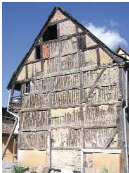
Abb. 2.10: Gefache aus Stakung mit Strohlehmbewurf mit Reparaturgefachen aus Lehm- und Ziegelsteinen
