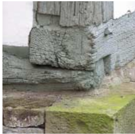
Abb. 3.14: Hakenförmiges Eckblatt; Fachwerkhaus, errichtet Ende des 17. Jahrhunderts
