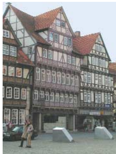
Abb. 2.5: Niederdeutsches Fachwerk in Hannoversch-Münden
