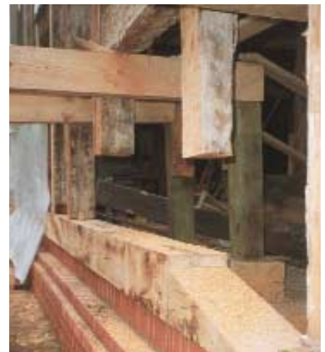
Abb. 4.6: Erneuerung Schwelle mit gemauertem Sockel (weitere Lösungen: siehe Abb. 4.10 und 4.11)
