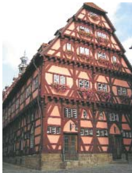
Abb. 2.3: Oberdeutsches Fachwerk, Rathaus Esslingen, erbaut 1432
