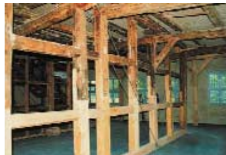
Abb. 4.4: Neue Schwelle und Gründung sowie teilweiser Ersatz der Holzsubstanz bei Ständern
