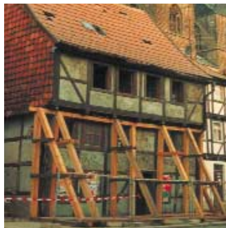
Abb. 4.12: Abstützung eines Fachwerkbaus
