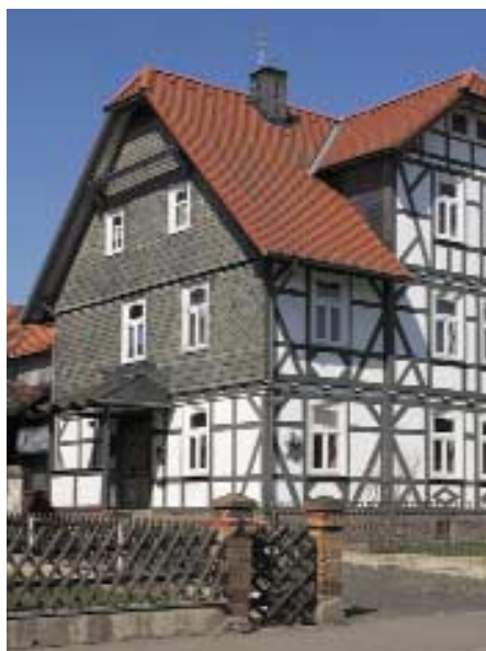
Abb. 2.8: Wetterschutz durch Verschieferung im hochbeanspruchten Bereich der Bewitterung
