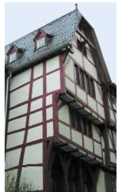
Abb. 2.2: Fachwerk in gemischter Bauweise: Vorderseite Stockwerkbauweise mit Auskragungen, Längsseiten Geschossbau, Wetzlar, erbaut im 14. Jahrhundert (Zeichnung aus [5])
