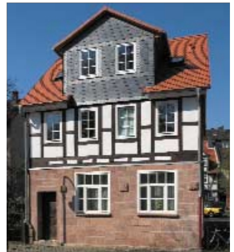
Abb. 3.13: Fachwerk auf einem Erdgeschoss aus Natursteinen
