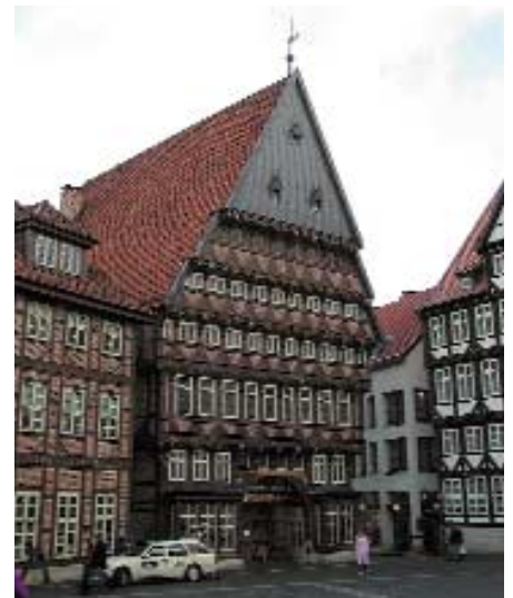
Abb. 3.8: Knochenhaueramtshaus Hildesheim, niederdeutsches Fachwerk mit Auskragungen, 1529 errichtet, 1945 zerstört, 1987/90 originalgetreu wiederaufgebaut
