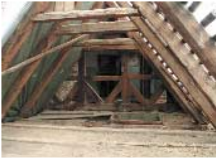
Abb. 3.2: Sparrendach mit Kehlbalcken
