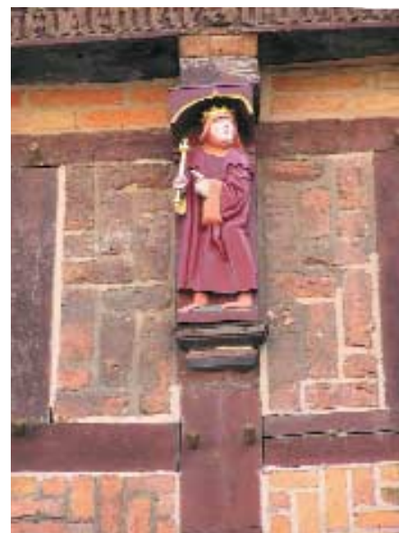
Abb. 2.11: Ausfachung mit Ziegelsteinen als Sichtmauerwerk, Fachwerkhaus Perleberg, erbaut im 16. Jahrhundert
