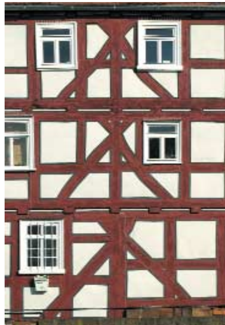
Abb. 3.12: Mitteldeutsch-hessisches Fachwerk, Strebenfigur „Mann“
