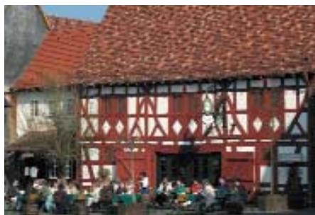
Abb. 5.2: Umnutzung eines Fachwerkgebäudes zum Hotel mit Gaststätte
