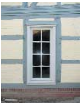
Nach neuer Fundamentierung und Ersatz der Grundschwelle, Instandsetzung der Stiele, neue Gefache aus Ziegel
