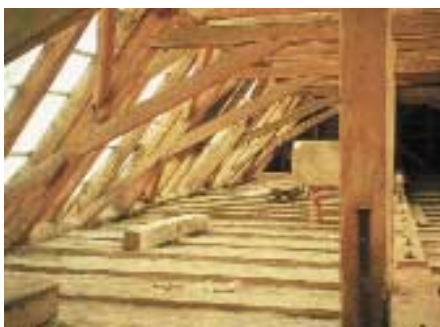
Abb. 3.3: Sparrendach mit liegendem Stuhl
